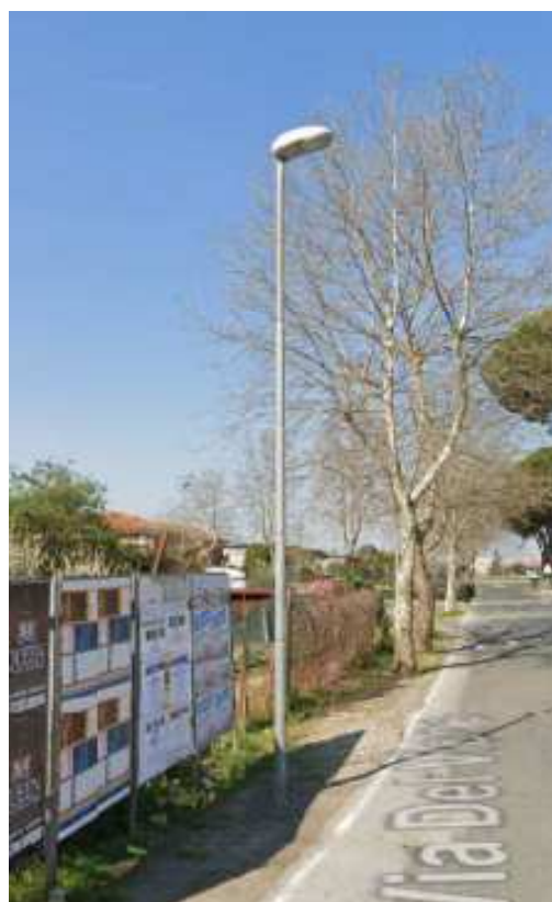
Figura 2 - Armatura stradale su testa palo dritto con un punto luce – tipo C
