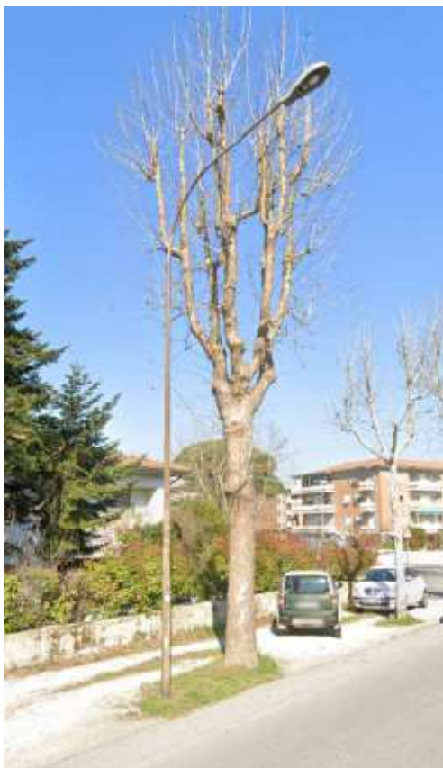
Figura 1 - Armatura stradale su sbraccio curvo - tipo A
