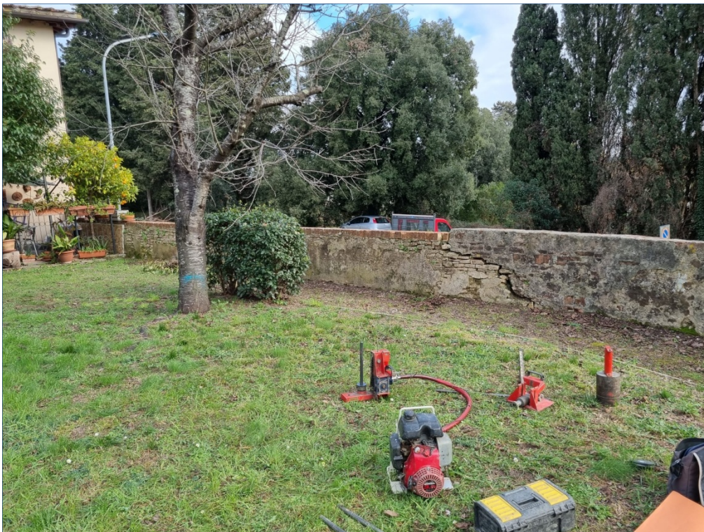
Figura 2: Postazione prova penetrometrica DIN 2
