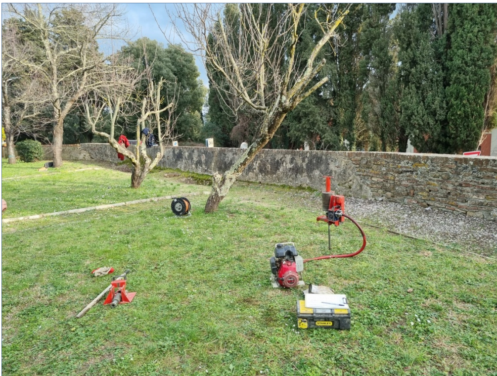
Figura 4: Postazione prova penetrometrica DIN 4
