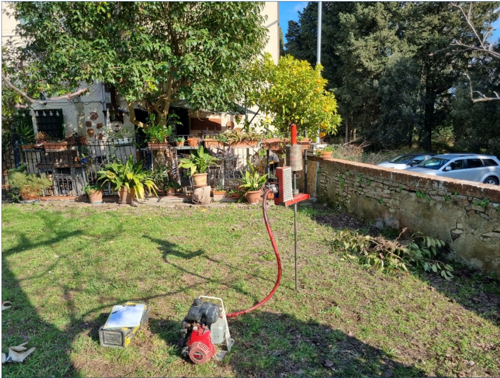
Figura 1: Postazione prova penetrometrica DIN 1
