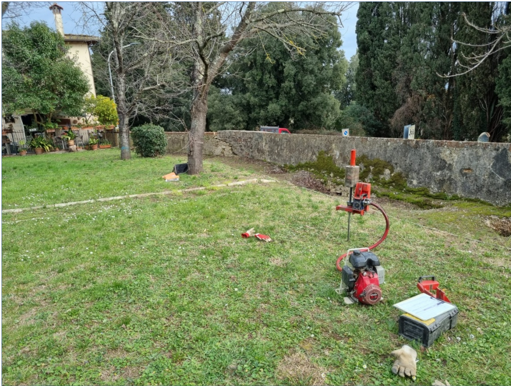
Figura 3: Postazione prova penetrometrica DIN 3
